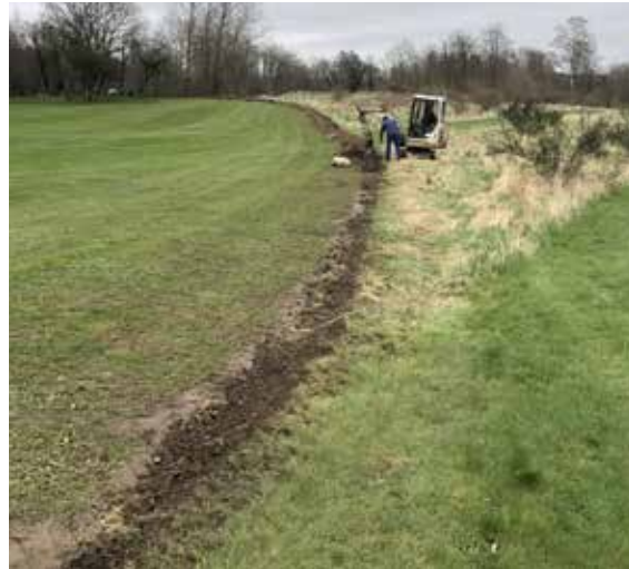
Denne kanal til fibernet er gravet af Onsdagsholdet.
